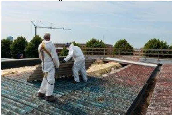
Foto:asbestsanering
